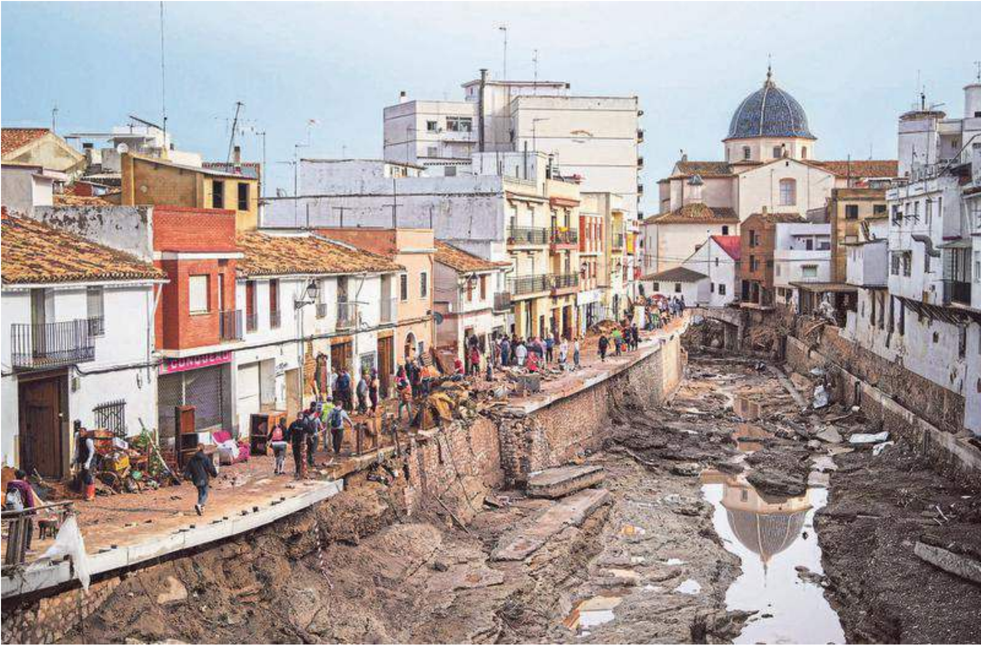
Zerstörtes Flussbett Der „Barranco“ in Chiva westlich von Valencia ist meist nur ein Rinnsal, doch nun trat das Wasser über die Mauern und beschädigte Häuser
